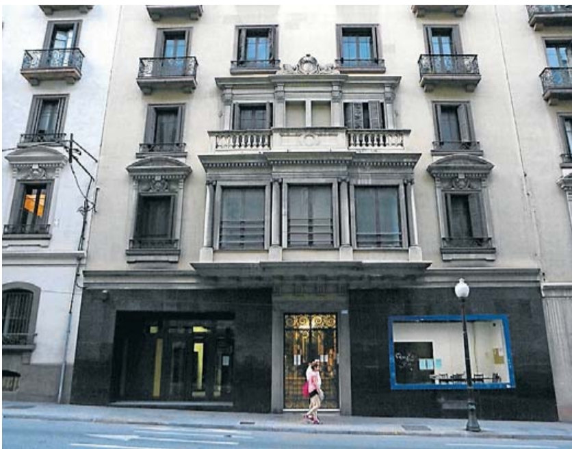
La façana del bloc 362 del carrer Balmes, on hi ha en marxa una reforma integral de l'edifici mentre encara hi viu una veïna. CÈLIA ATSET
