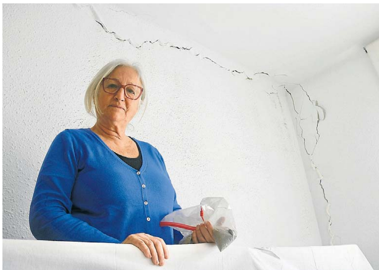
Lola Sánchez, una de les veïnes afectades per les esquerdes provocades pel soterrament de Montcada, a casa seva. ACN
