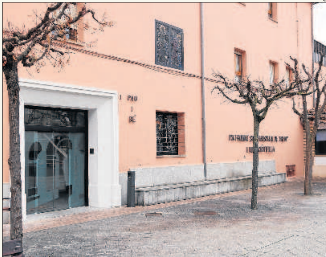
Imatge d'arxiu de la façana de la residència de Tremp.
