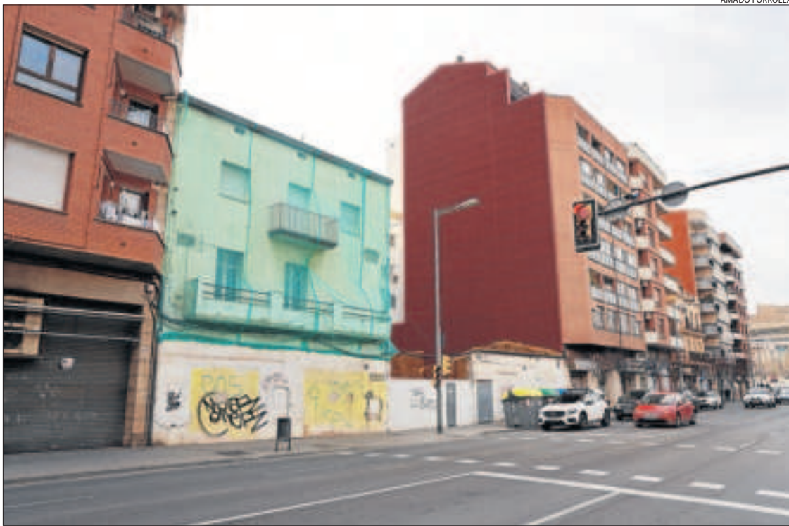
L'edifici situat al número 22 d'avinguda de les Garrigues, a Cappont, amb malla protectora.
